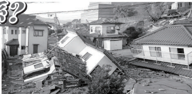
熊本地震で倒壊した家屋
